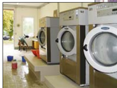
1994: Hallenreinigung mit einem kabelfreien Reinigungsautomaten.
